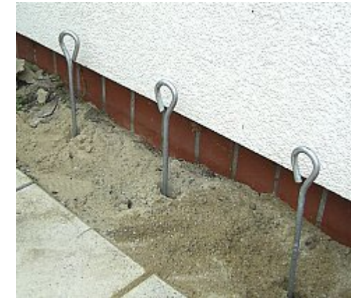
Montage der Erdanker, vertikale Seile
